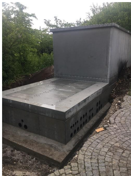
Trafostation mit Vorschacht
